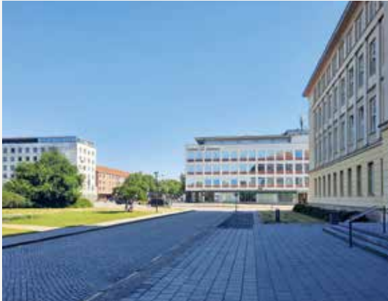
Eisenhüttenstadt atmet die Baukultur der DDR.
