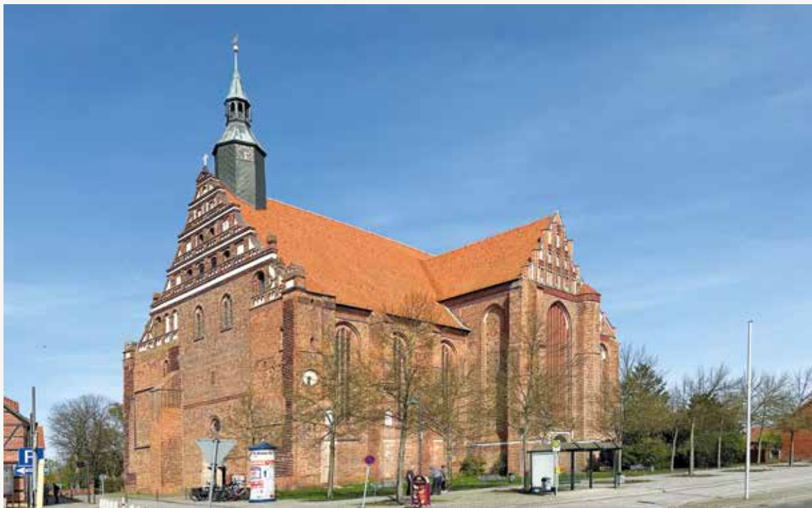
Mit ihrem neuen Dach leuchtet die Kirche schon von Weitem.
